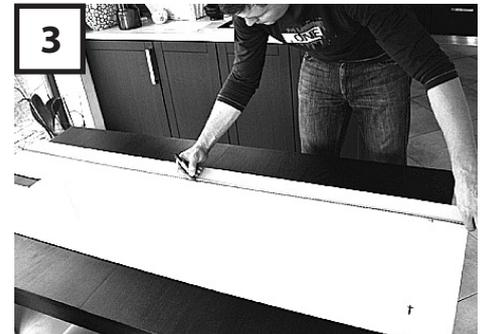
Verbinden Sie die (aus Bild 3) gezeichneten Punkte und teilen Sie die Länge in max. je 80 cm.
