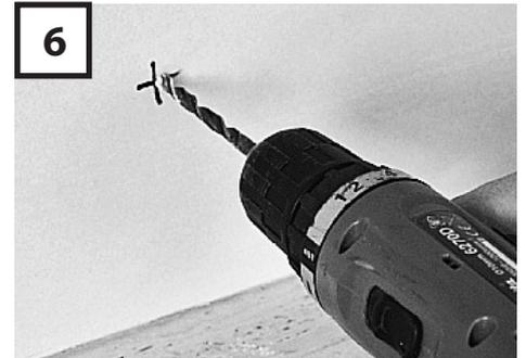
Bohren Sie Löcher in die Wand auf die von Ihnen gezeichnete Punkte (+/- 2cm) und platzieren Sie die Dübel in jede Öffnung.
